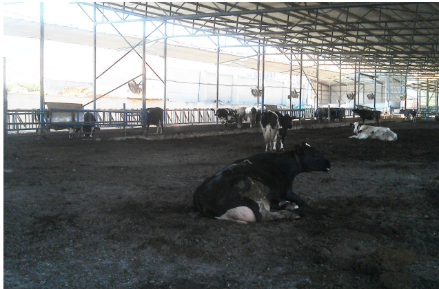
Køerne foretrakker at æde ved pladser på foderbordet tæt ved de ventilatorer der samtidig sprinkler køerne med vand.
